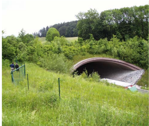
Grünbrücke Schwarzgraben an der B 31 neu, Bodensee
