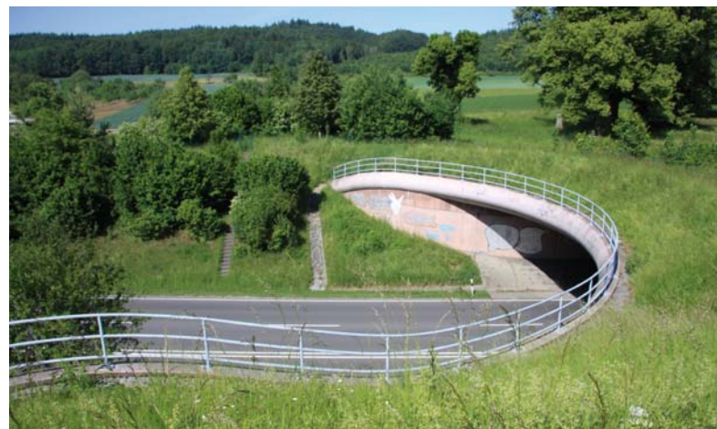
Einbindung und Gestaltung einer Grünbrücke
