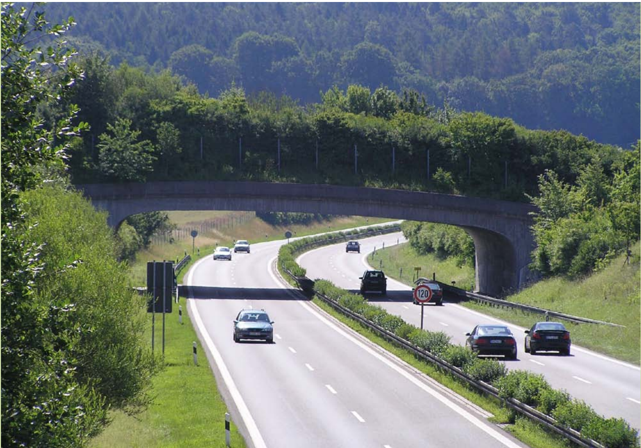
Grünbrücke Hohenreute an der B 33 neu, Bodensee
