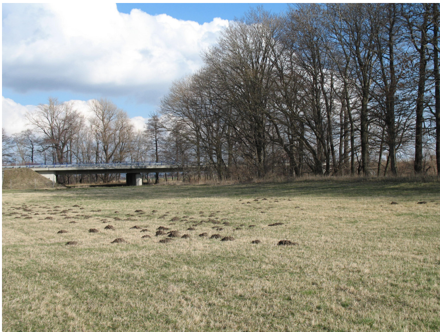
Abbildung 8: Blick auf die Ilsebrücke in Richtung Norden. Die zuleitenden Strukturen sind keinesfalls ausreichend.
