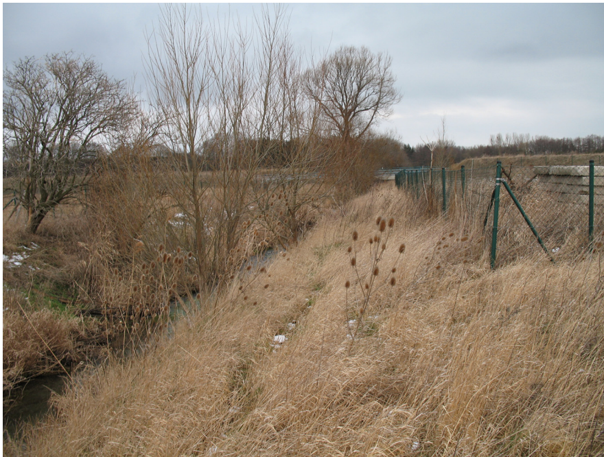
Abbildung 5: Im Hintergrund befindet sich die Schamlahbach-Brücke. Auf der rechten Seite ist der Zaun des Regenauffangbeckens zu sehen, der unbedingt zu entfernen ist, damit das Wild ungehindert in Richtung Eckerbrücke ziehen kann.
