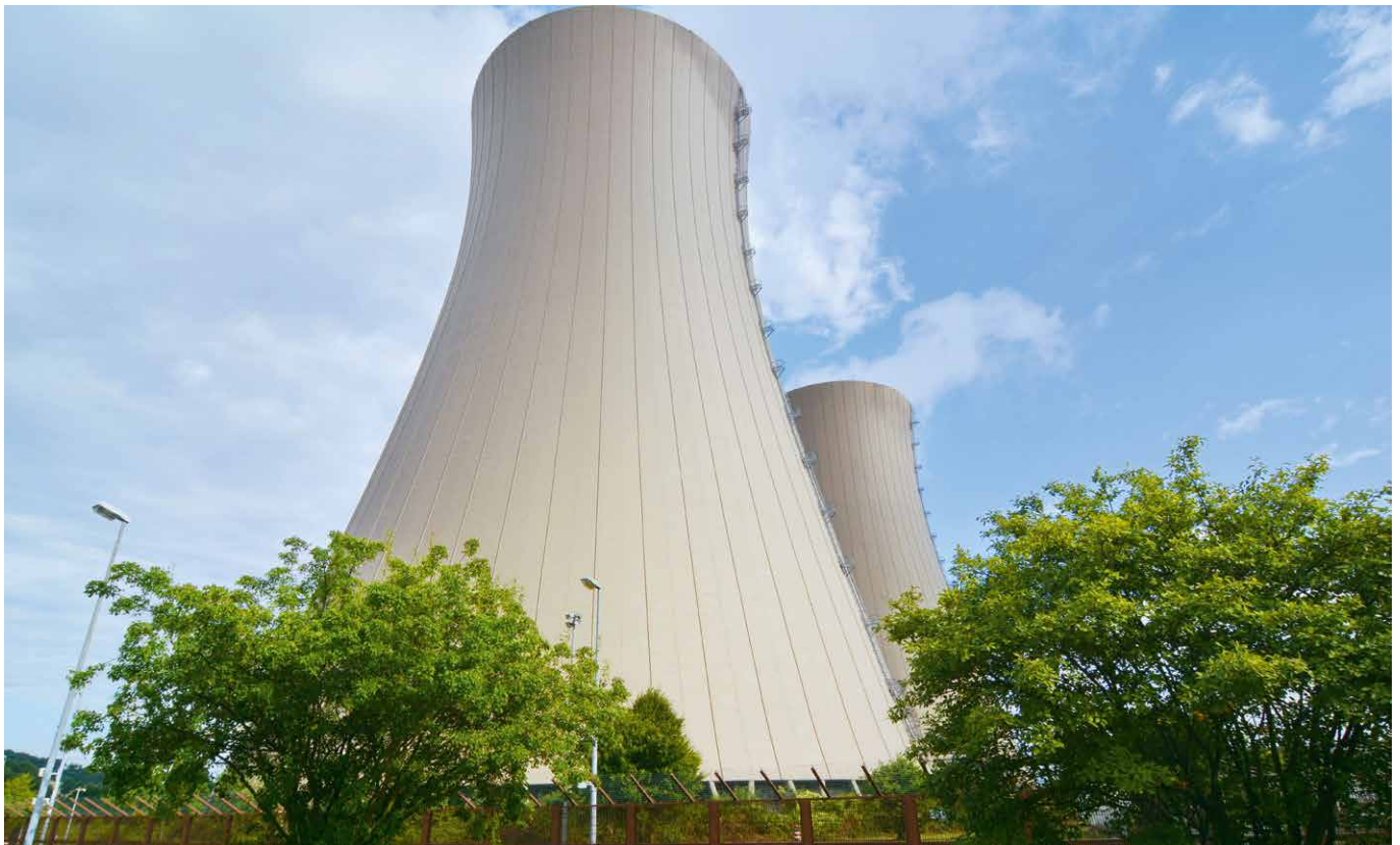
Das Atomkraftwerk in Grohnde läuft weiter – doch über Maßnahmen als Reaktion auf den EU-Stresstest gibt es keine Informationen.
