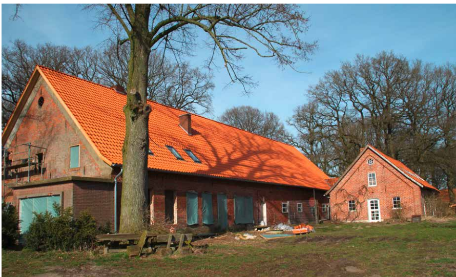
Das neue Dach des Hof Wendbüdel erstrahlt im Sonnenschein.
