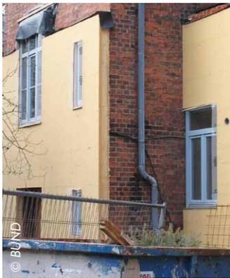
Auch Altbauten können sinnvoll gedämmt werden, wie hier mit einer 20 cm dicken Zelluloseschicht
